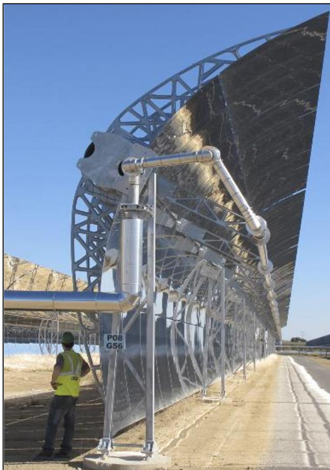
**Figura 16: Collettore parabolico lineare SNT2**
