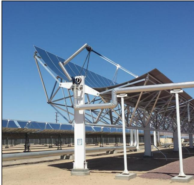
**Figura 15: Collettore parabolico lineare LAT 8.0**
