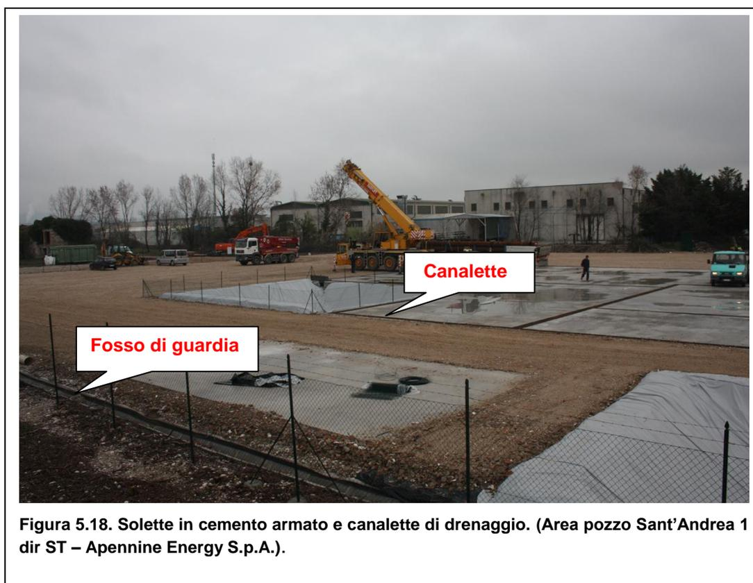
**Figura 5.18. Solette in cemento armato e canalette di drenaggio. (Area pozzo Sant'Andrea 1 dir ST – Apennine Energy S.p.A.).**
