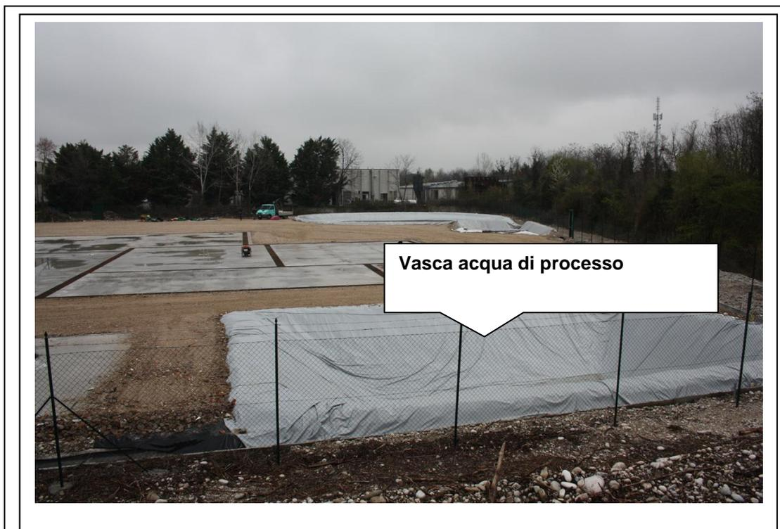
**Figura 5.19. Vasca acque di processo (Area pozzo Sant'Andrea 1 dirST – Apennine Energy S.p.A.); nel caso in oggetto le vasche saranno invece in cemento armato.**
